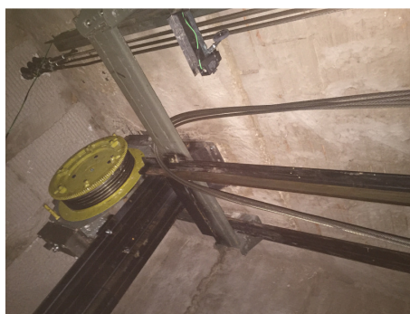
Máquina sem espaço para manutenção e com os cabos desinstalados.
