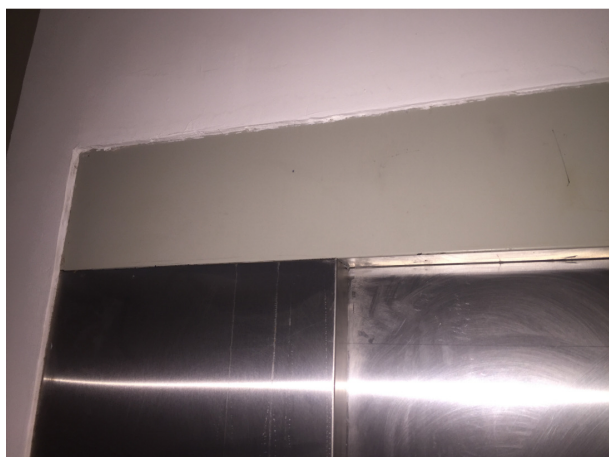
Batente da porta diferente com acabamento diferente da porta.
