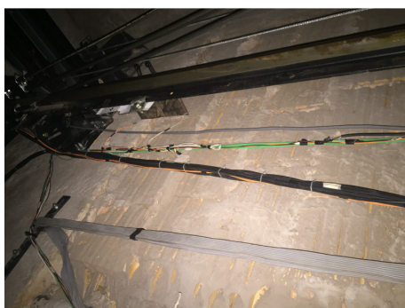
Fiação exposta na caixa de corrida
