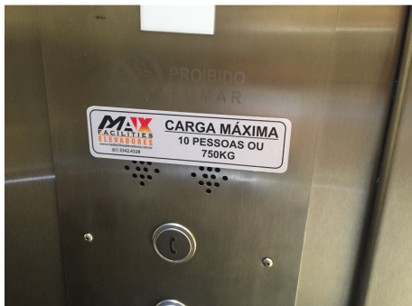
Capacidade em desconformidade com o tamanho da cabine.
