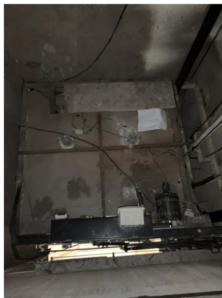
Falta da caixa de conexão, fiação exposta e sem proteção de cabine.
