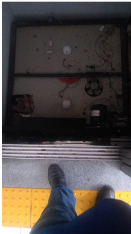
Topo da cabine sem proteção, sem caixa de conexão, cabine espremida na caixa de corrida.
