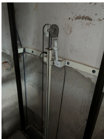
Polia do pistão sem proteção e com estrutura não compatível com o tamanho o equipamento.
