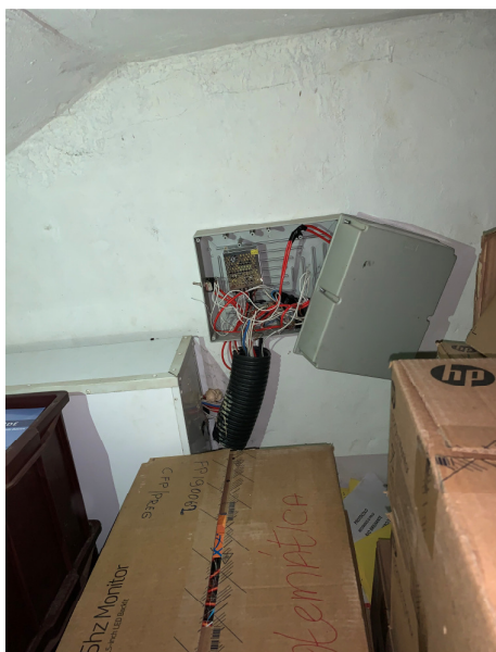
Quadro do comando sem marcação com gambiarras e jumpers, sem proteção.
