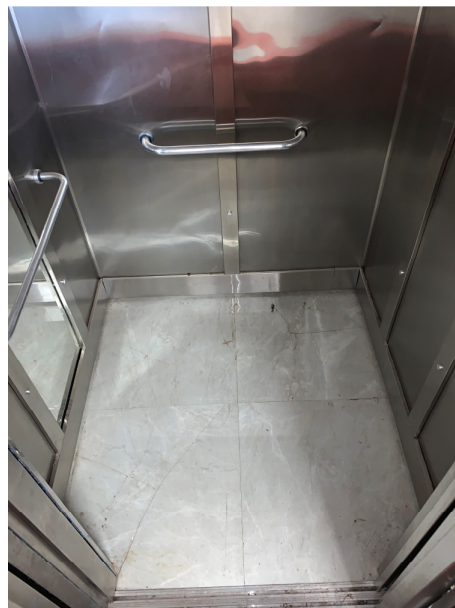
Piso da cabine danificado, com possível dano na estrutura.
